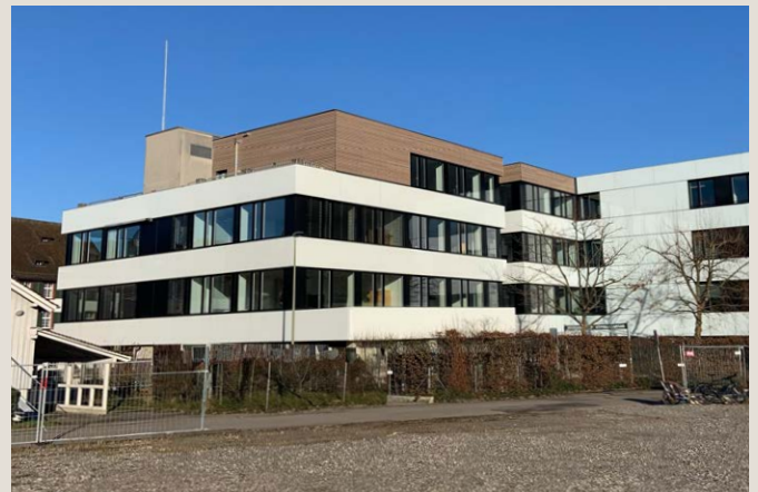
Gebäude B, nach Abschluss der Umbauarbeiten
