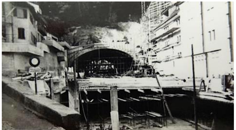
Schlossbergtunnel und Tunnelgarage
