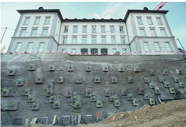
Ankerwand beim Bezirksgebäude
