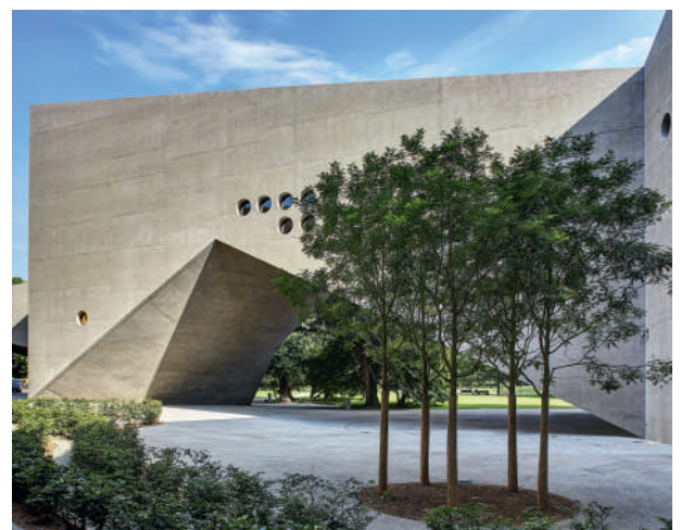
Der Erweiterungsbau mit Blick auf den Platzspitzpark.
